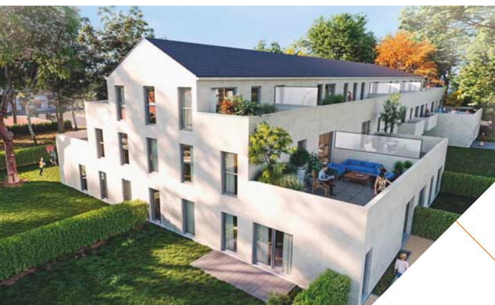
« Les Terrasses des Arts », programme en cours de réalisation à Lagny-sur-Marne (77)
